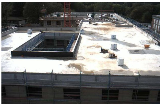
[Baustelle Haus 60; Stand 05.09.2016]
