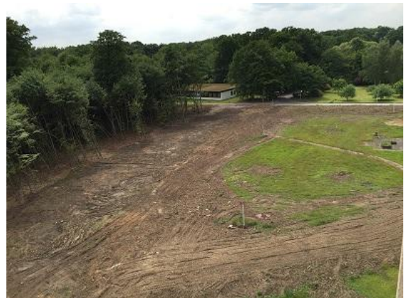
[Ansicht Baufeld vom Dach Haus 59]
