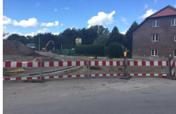
[Ansicht Baustellenzufahrtsstraße Albert-Einstein-Str. / Gutshof]
