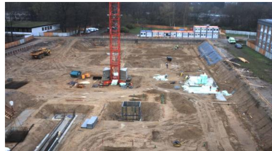
[Ansicht Baufeld vom Dach Haus 59 Stand 25.11.15]
