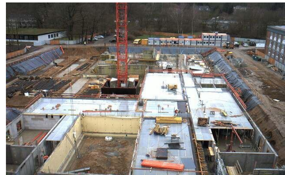
(Baustelleneinrichtung Haus 60 Stand 02.03.2016)
