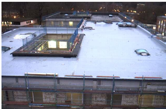
(Baustelle Haus 60; Stand 11.01.2017)
